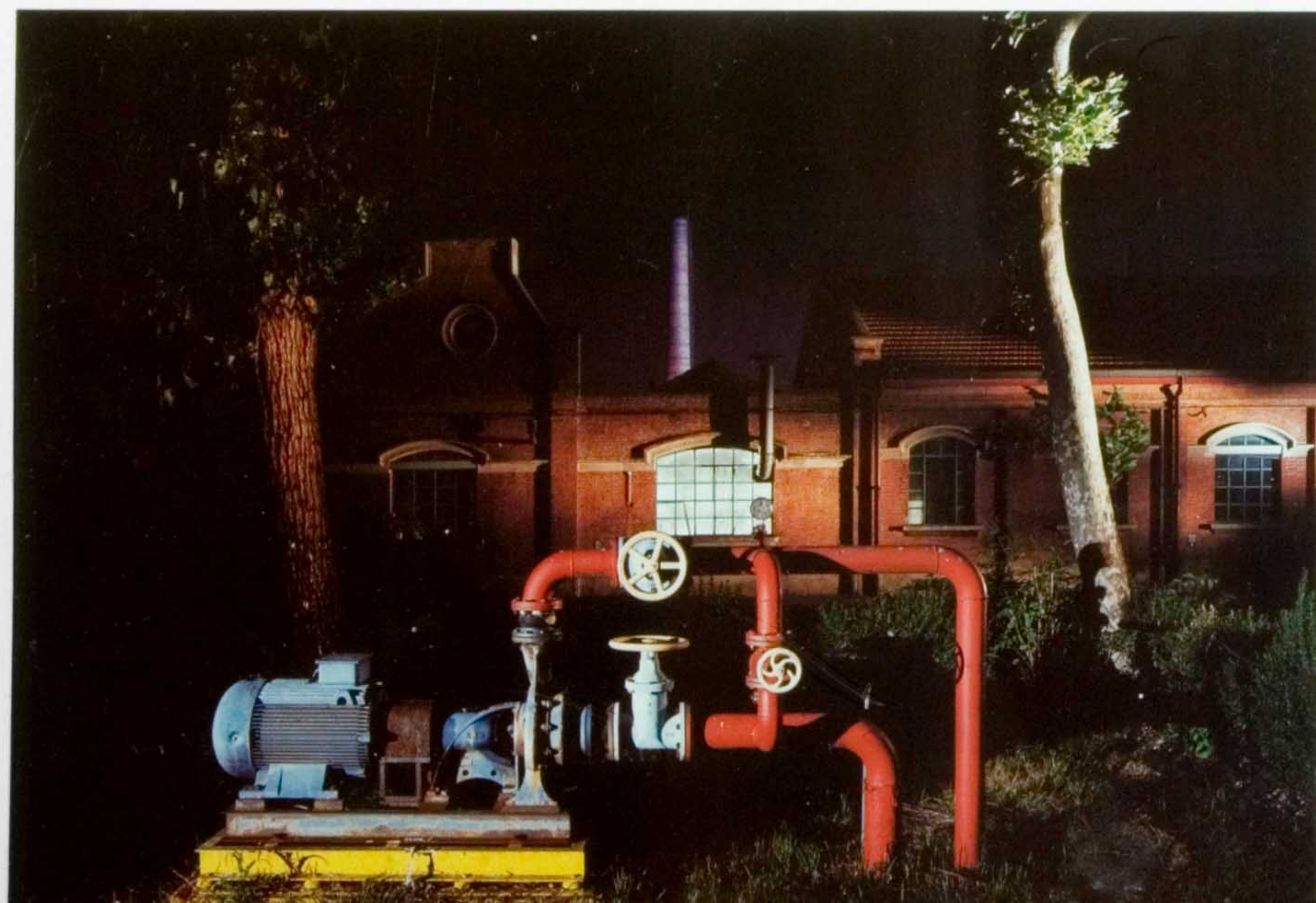
Dal from "Bovisa in luce" (Bovisa in Light), indagine fotografica per AEM/photographic survey for Milan Electricity Company, "La produzione del gas", 1998.
