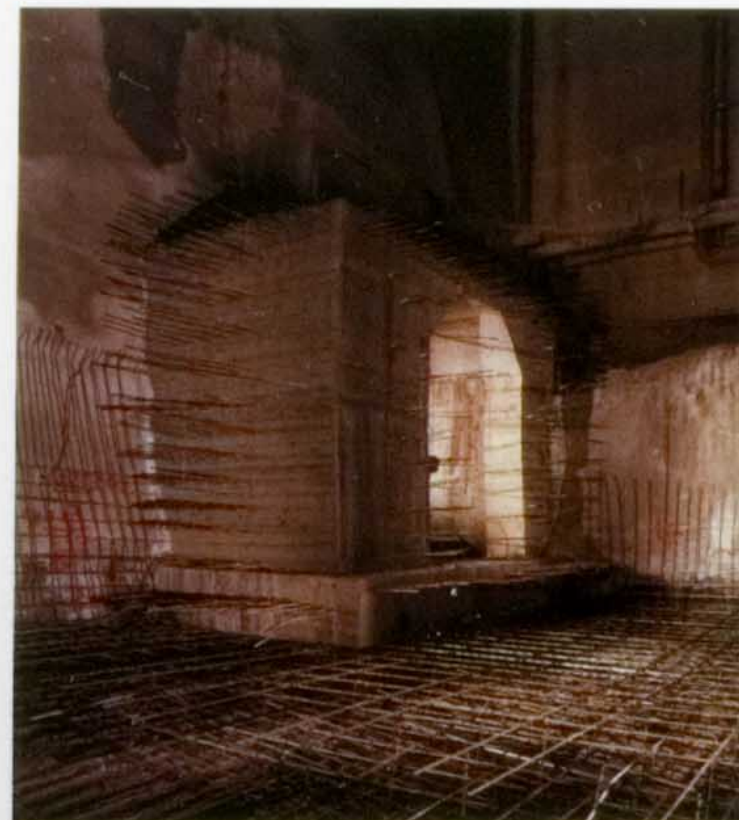
A fianco Premadio 2, due immagini della fondazione nuova sala macchine
